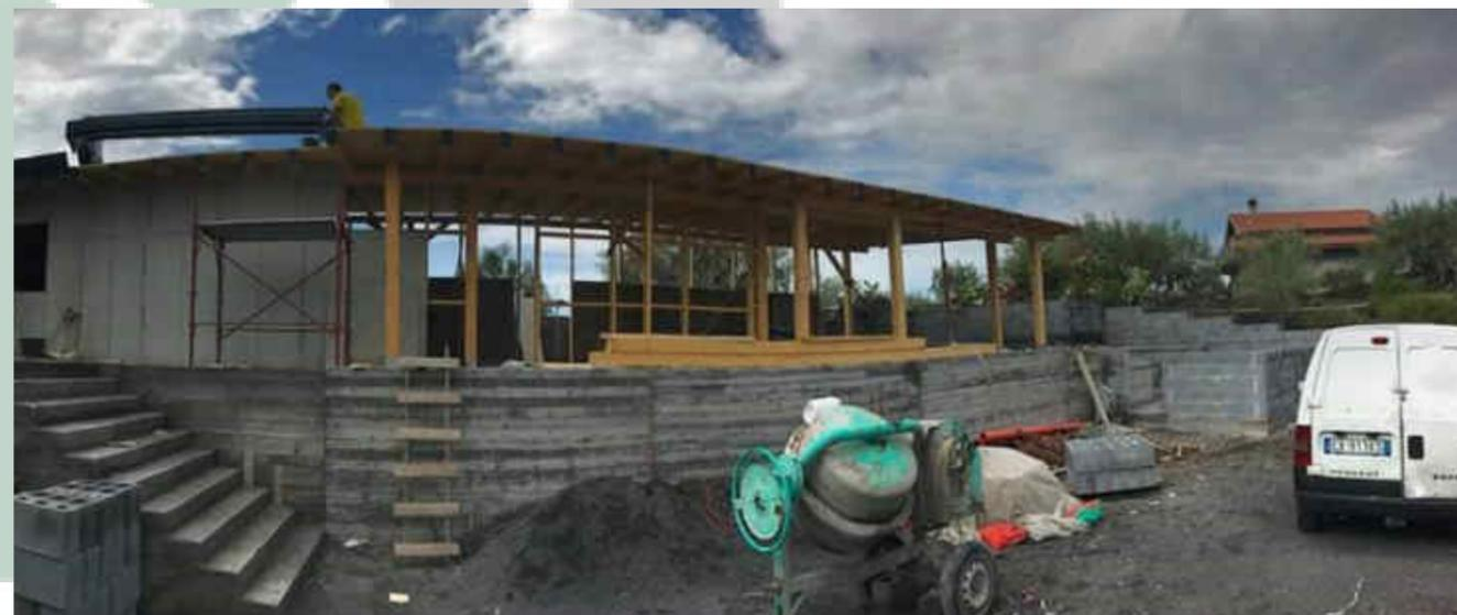
Fornitura e posa in opera di pareti perimetrali esterne con la predisposizione di vani porte e finestre, realizzate con struttura portante in legno lamellare "GL24H".
